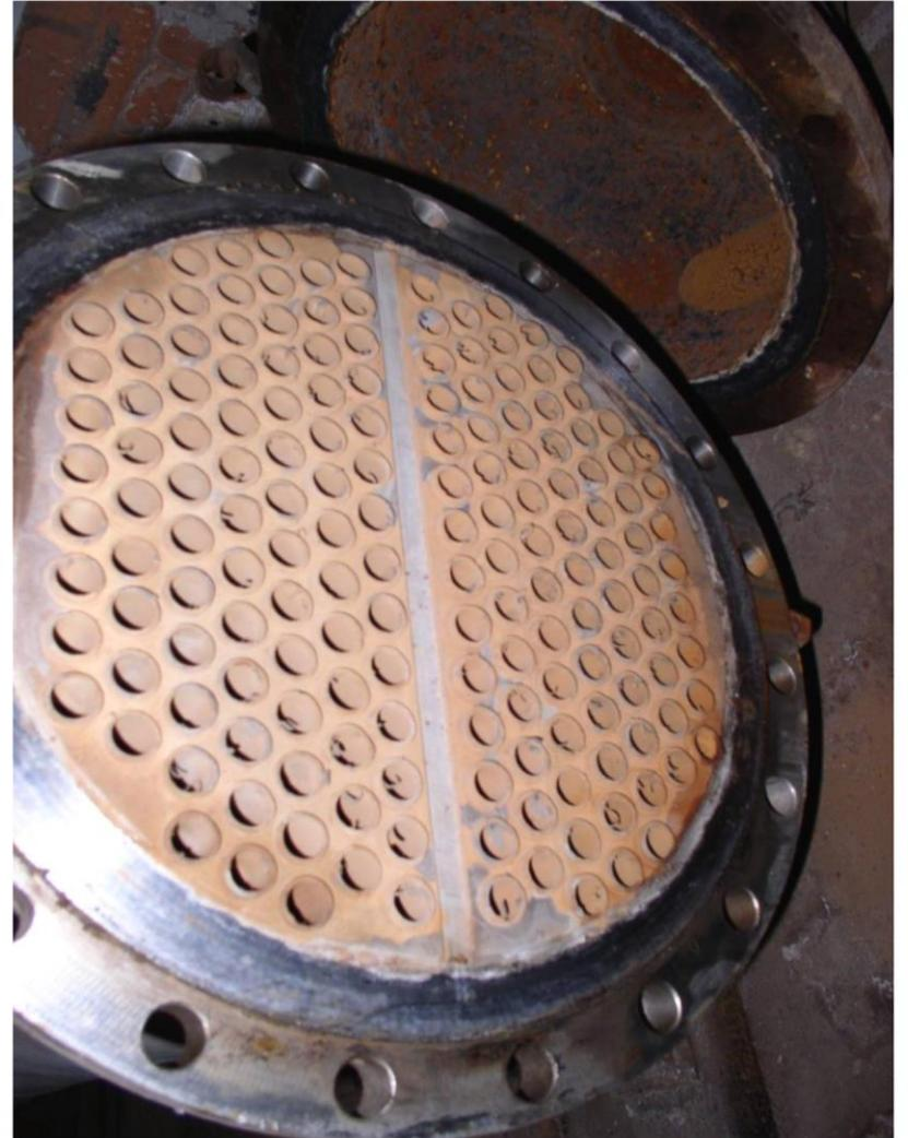
Вскрытие установки БАУ на пароводяных теплообменниках системы горячего водоснабжения и чистый теплообменник как результат работы установки.
